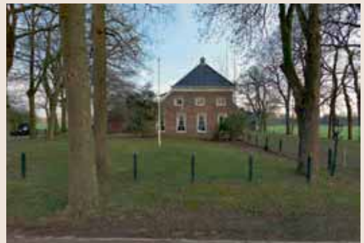
▲ Boerderij 'Huize Den Dollard', aan de Linthorst Homanweg 1 te Oudemolen, 2016 (foto: RCE).
